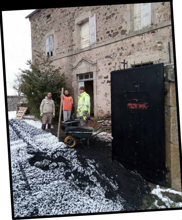
Début du chantier de réhabilitation de l'ancien presbytère
