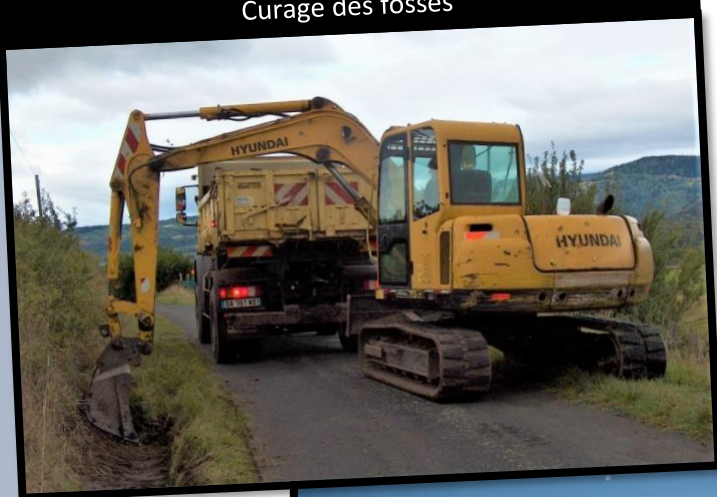
Curage des fossés
