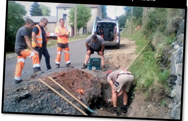
Réparation sur le réseau d'eau potable
