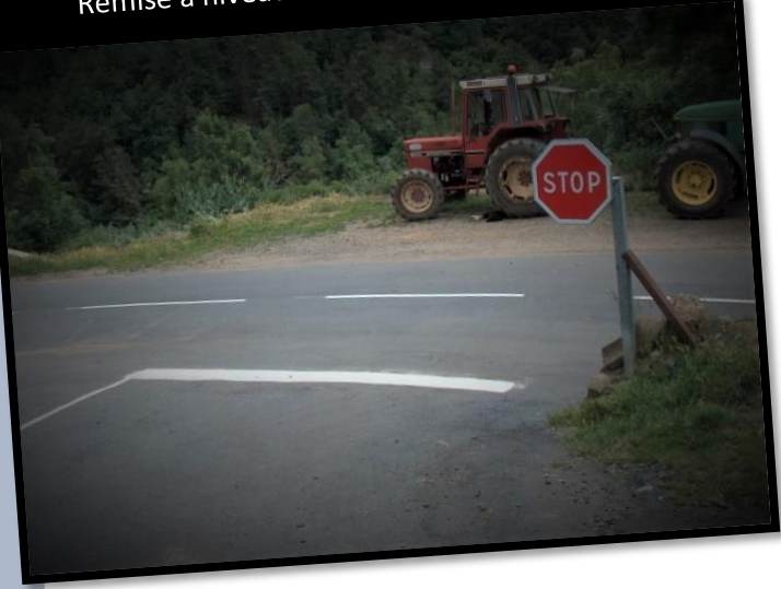
Remise à niveau de la signalisation routière
